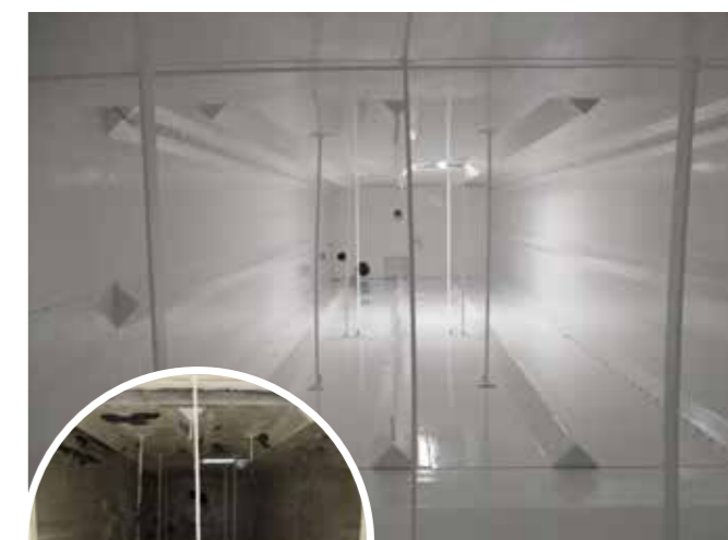
Applicazione di nuovo rivestimento resinoso interno di celle adibite allo stoccaggio di farina
