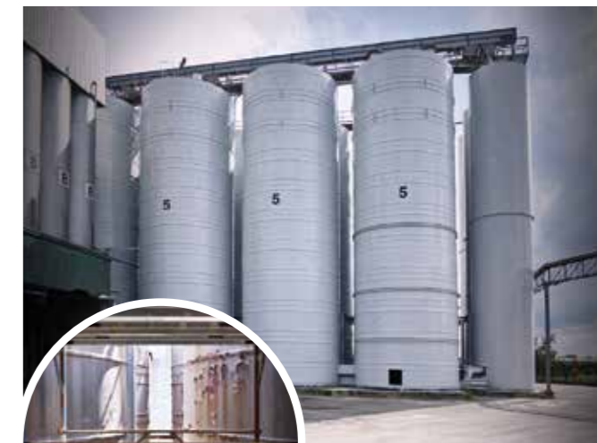
Manutenzione, rinforzo delle zone di giunzione e protezione anticorrosiva di un gruppo sili stoccaggio cereali
