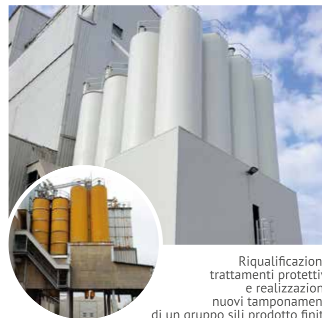
Demolizione e costruzione in opera di una batteria di silos metallici adibiti allo stoccaggio di alimenti zootecnici
