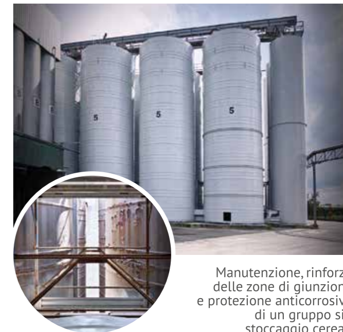
Demolizione e costruzione in opera di una batteria di silos metallici adibiti allo stoccaggio di alimenti zootecnici
