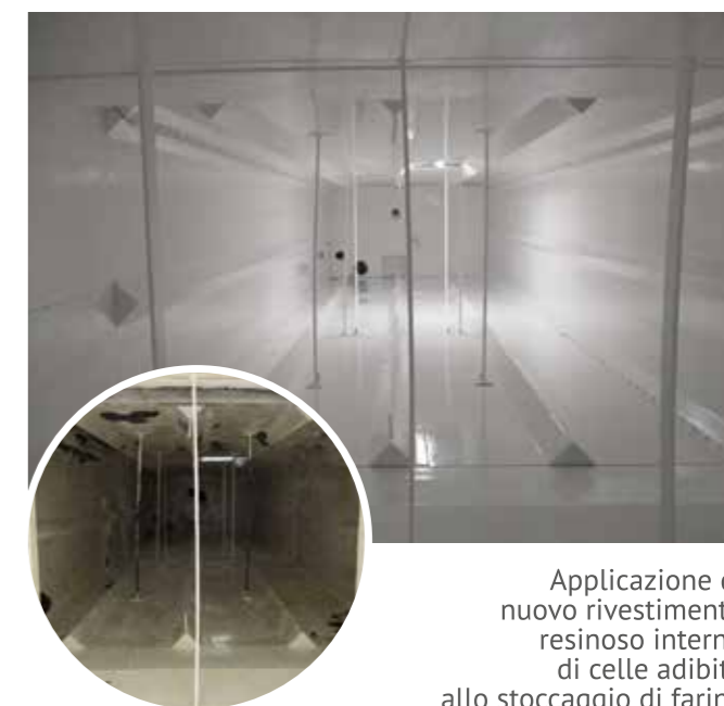
Manutenzione, rinforzo delle zone di giunzione e protezione anticorrosiva di un gruppo silos stoccaggio cereali
