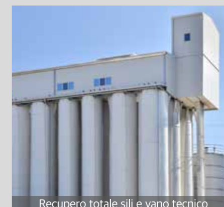
Recupero totale sili e vano tecnico
