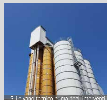
Sili e vano tecnico prima degli interventi
