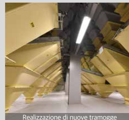
Realizzazione di nuove tramogge
