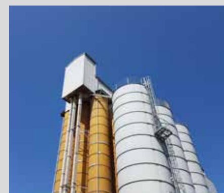
Sili e vano tecnico prima degli interventi
