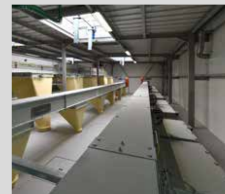
Nuova copertura, lucernari e tamponamenti
