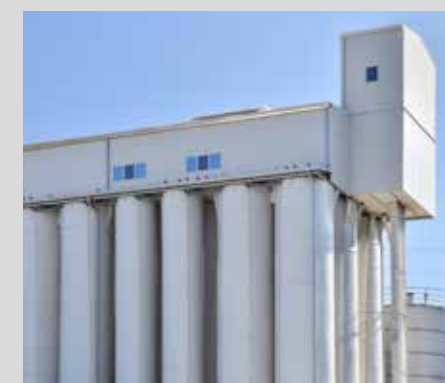
Recupero totale sili e vano tecnico
