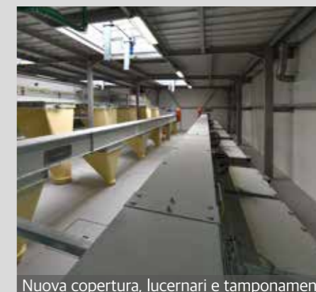
Nuova copertura, lucernari e tamponamenti
