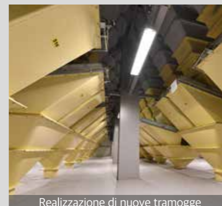
Realizzazione di nuove tramogge
