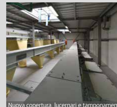
Nuova copertura, lucernari e tamponamenti
