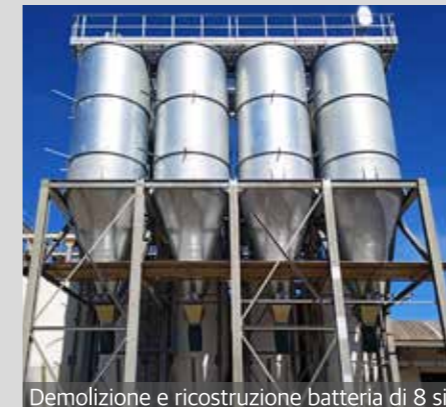
Demolizione e ricostruzione batteria di 8 silos
