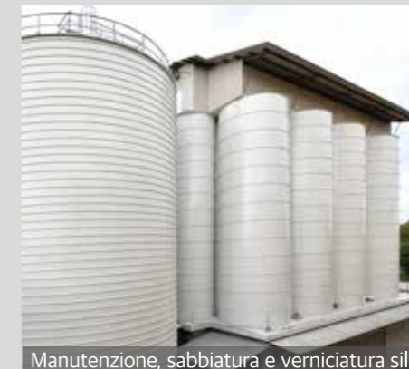
Manutenzione, sabbiatura e verniciatura silos
