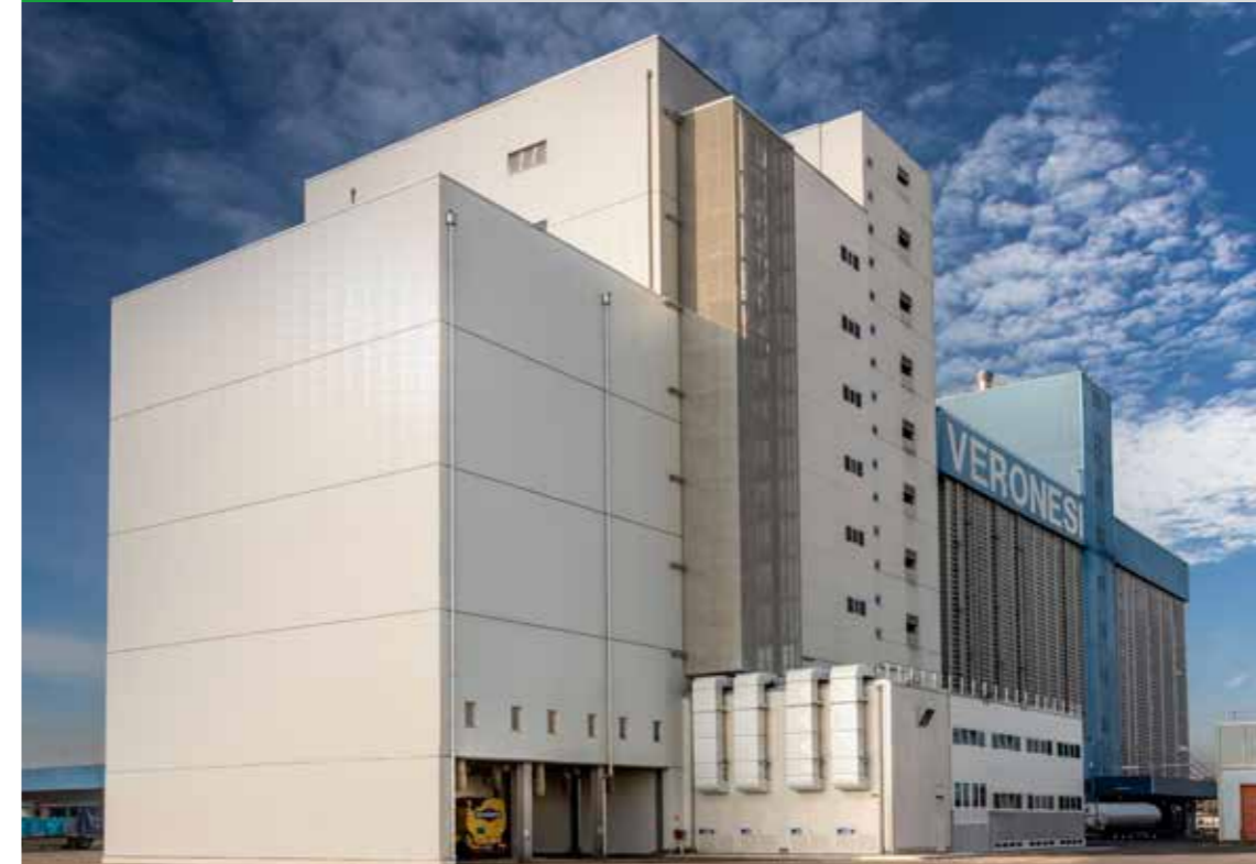
Nuova realizzazione di 92 silos, torre di lavorazione, scala di emergenza e montacarichi
