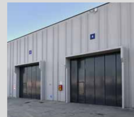
Elementi di facciata in calcestruzzo risanati
