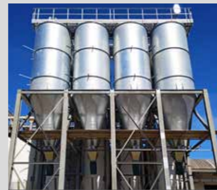
Demolizione e ricostruzione batteria di 8 silos
