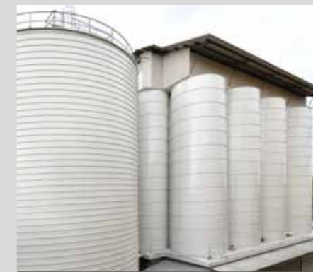
Manutenzione, sabbiatura e verniciatura silos
