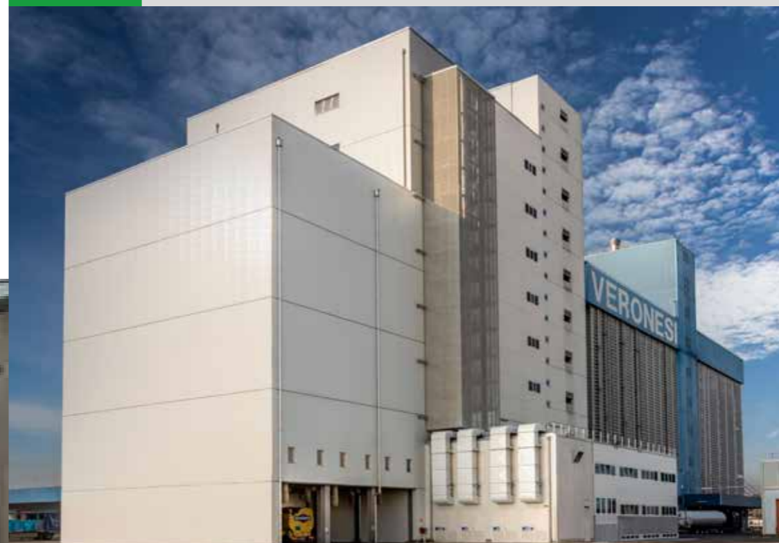
Nuova realizzazione di 92 silos, torre di lavorazione, scala di emergenza e montacarichi
