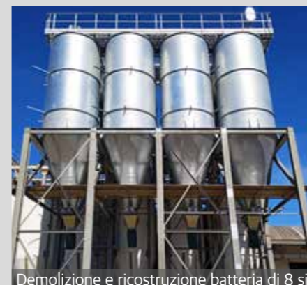
Demolizione e ricostruzione batteria di 8 silos
