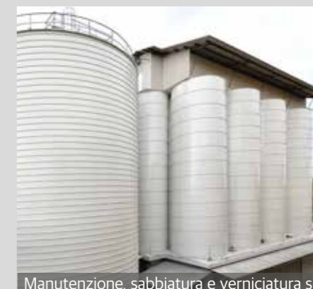
Manutenzione, sabbiatura e verniciatura silos
