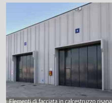
Elementi di facciata in calcestruzzo risanati
