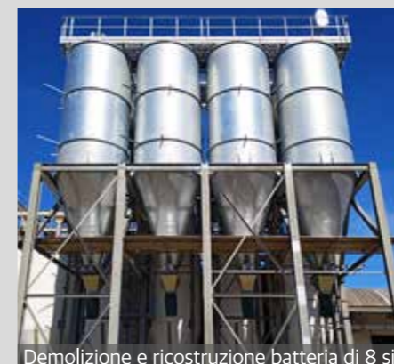
Demolizione e ricostruzione batteria di 8 silos
