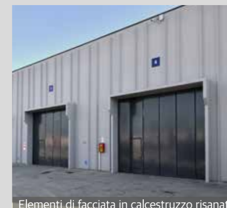
Elementi di facciata in calcestruzzo risanati
