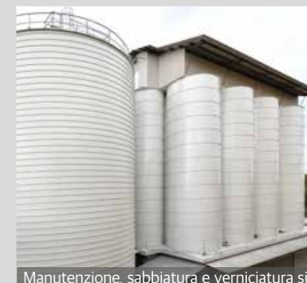
Manutenzione, sabbiatura e verniciatura silos
