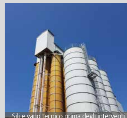
Sili e vano tecnico prima degli interventi
