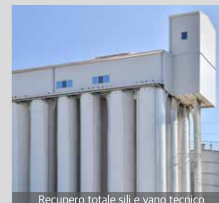
Recupero totale sili e vano tecnico
