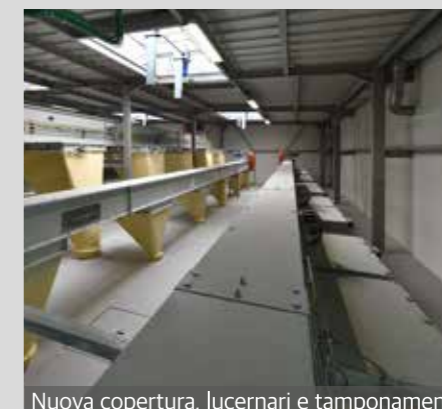
Nuova copertura, lucernari e tamponamenti
