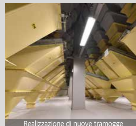
Realizzazione di nuove tramogge
