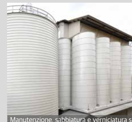
Manutenzione, sabbiatura e verniciatura silos
