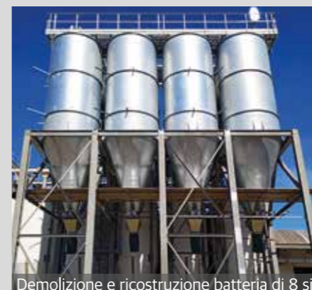
Demolizione e ricostruzione batteria di 8 silos
