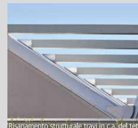
Risanamento strutturale travi in c.a. del tetto
