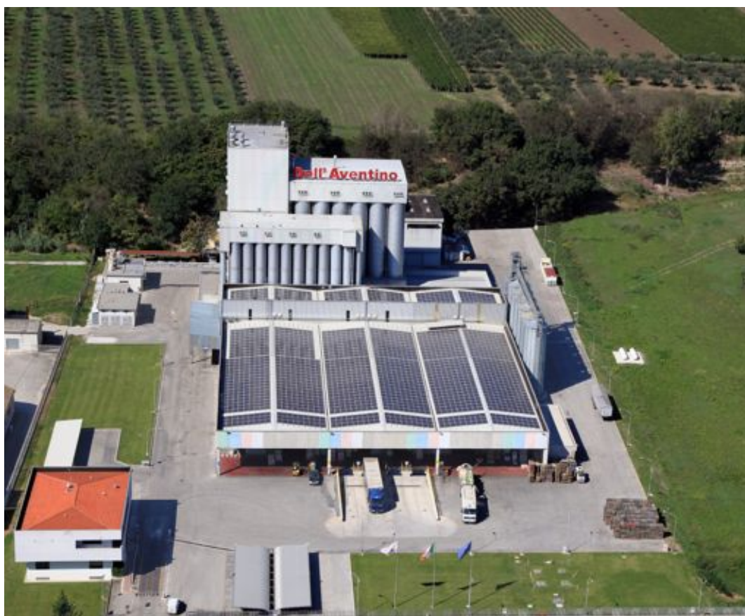
Il nuovo impianto fotovoltaico installato sul tetto dello stabilimento dell'azienda
