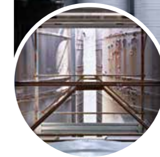
Manutenzione, rinforzo delle zone di giunzione e protezione anticorrosiva di un gruppo silo stoccaggio cereali
