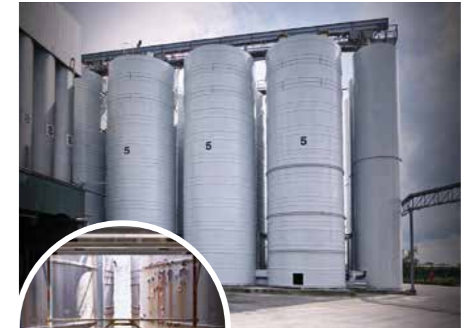
Manutenzione, rinforzo delle zone di giunzione e protezione anticorrosiva di un gruppo silo stoccaggio cereali
