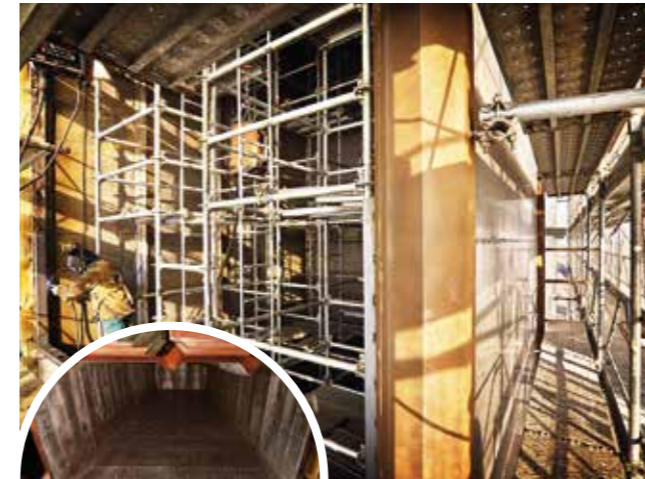
Demolizione e costruzione in opera di una batteria di silo metallici adibiti allo stoccaggio di alimenti zootecnici
