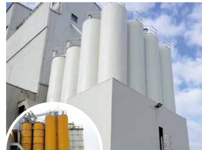
Riqualificazione, trattamenti protettivi e realizzazione nuovi tamponamenti di un gruppo silo prodotto finito
