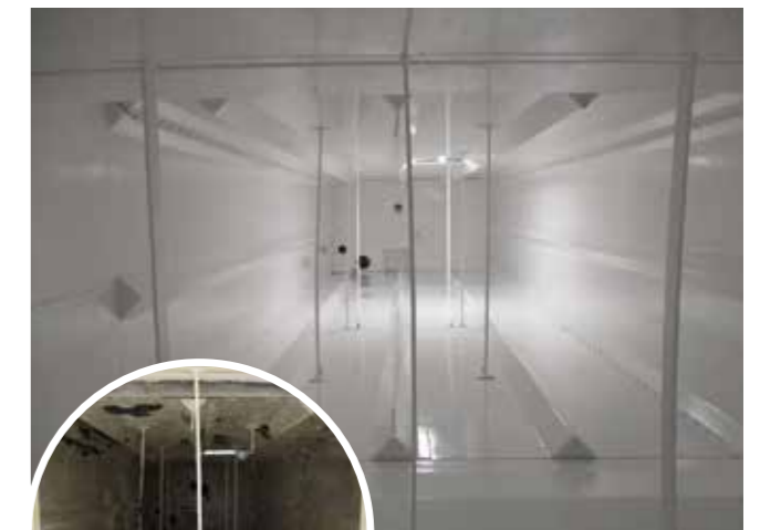
Applicazione di nuovo rivestimento resinoso interno di celle adibite allo stoccaggio di farina
