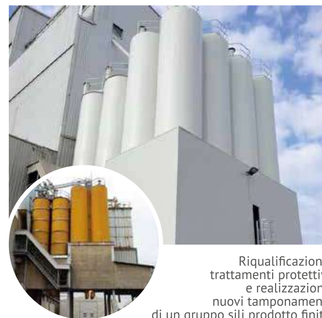
Demolizione e costruzione in opera di una batteria di silo metallici adibiti allo stoccaggio di alimenti zootecnici
