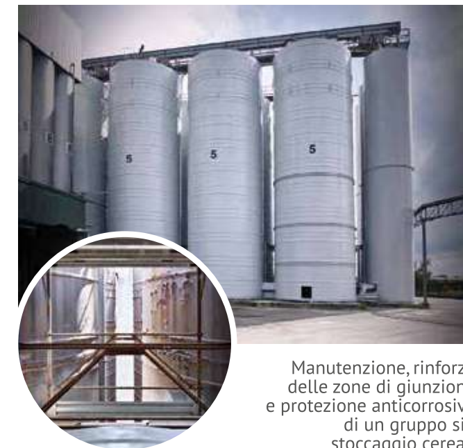
Demolizione e costruzione in opera di una batteria di silo metallici adibiti allo stoccaggio di alimenti zootecnici
