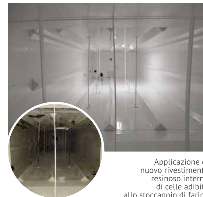
Manutenzione, rinforzo delle zone di giunzione e protezione anticorrosiva di un gruppo silo stoccaggio cereali
