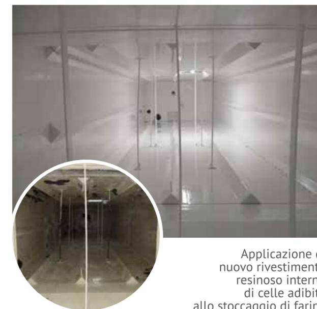
Applicazione di nuovo rivestimento resinoso interno di celle adibite allo stoccaggio di farina
