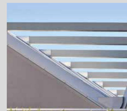
Risanamento strutturale travi in c.a. del tetto
