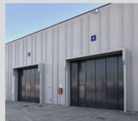
Elementi di facciata in calcestruzzo risanati
