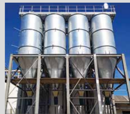
Demolizione e ricostruzione batteria di 8 silos
