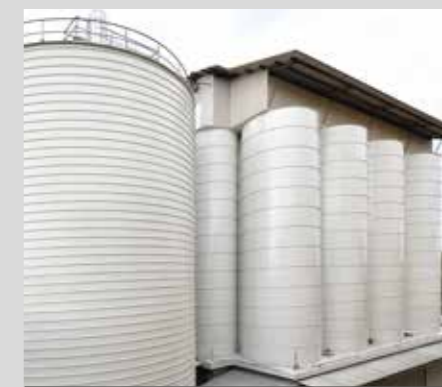
Manutenzione, sabbiatura e verniciatura silos
