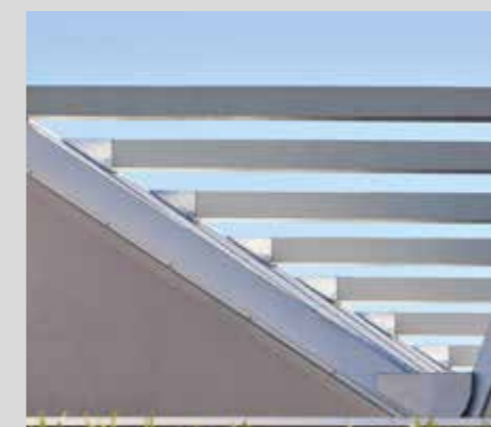
Risanamento strutturale travi in c.a. del tetto
