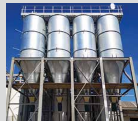
Demolizione e ricostruzione batteria di 8 silos
