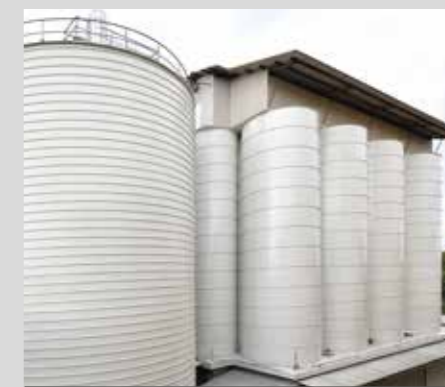
Manutenzione, sabbiatura e verniciatura silos
