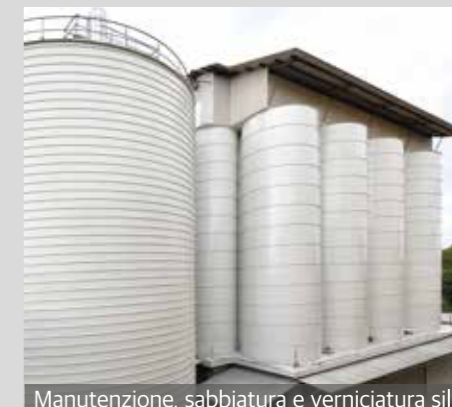
Manutenzione, sabbiatura e verniciatura silos
