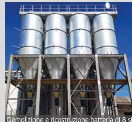
Demolizione e ricostruzione batteria di 8 silos
