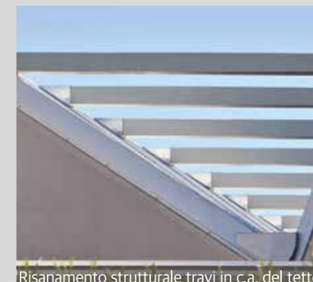
Risanamento strutturale travi in c.a. del tetto
