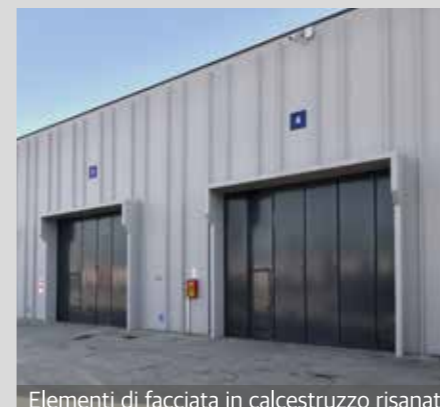
Elementi di facciata in calcestruzzo risanati
