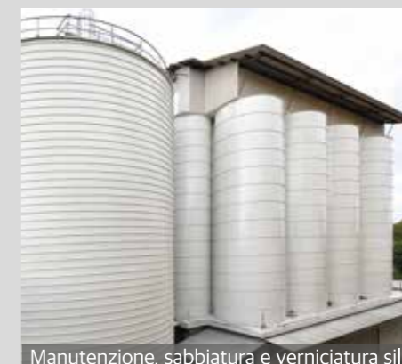
Manutenzione, sabbiatura e verniciatura silos
