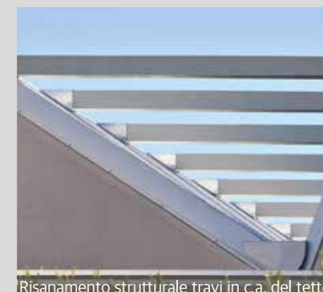
Risanamento strutturale travi in c.a. del tetto
